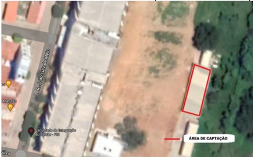
Figura 2 – Vista do telhado onde seria implantada a área de captação.
